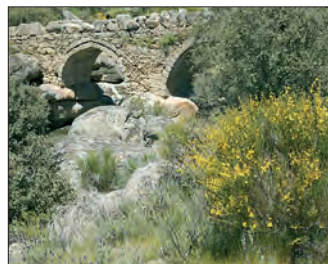
Puente de la Fonseca.
