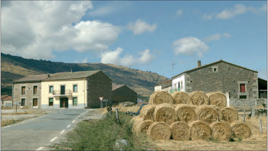
Ejemplos de construcciones de mampostería.
