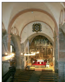
Interior de la iglesia.
