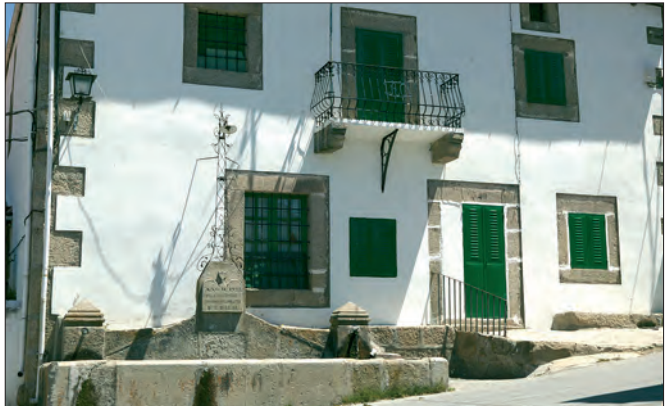
Revoco de mortero, dejando a la vista los sillares de las esquinas y los vanos.
