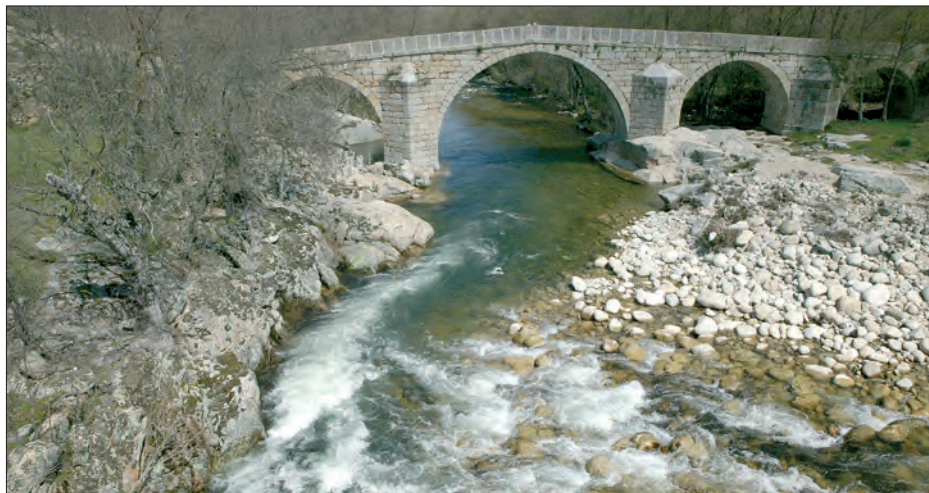
Puente de Tormellas.
