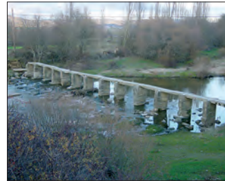
Puente pasarela en Palacios de Corneja.
