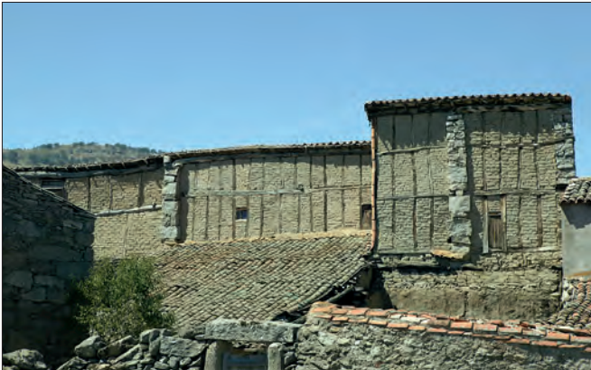
Construcción de adobe.
